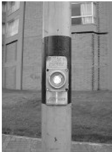
Fotografía 4.7 Semáforo actuado peatonal. Avenida Boyacá con avenida Iberia.
