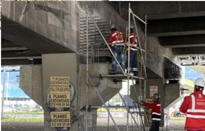
Obras para el reforzamiento estructural de puentes vehiculares y actividades complementarias, tendientes a optimizar y mejorar la capacidad estructural de los mismo, que conlleven a la actualización normas sísmica vigentes.
