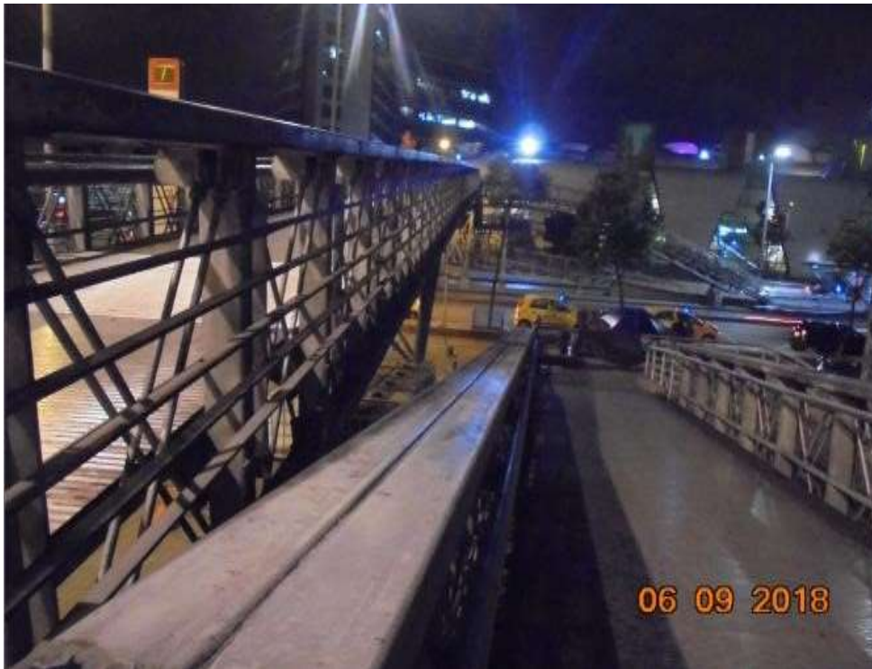
Puente Peatonal No. 42 Av. Medellín Kra 71 Centro Comercial Titán Antes de actividades lavado baranda tubular rampa de acceso costado sur. Actividad Nocturna.
