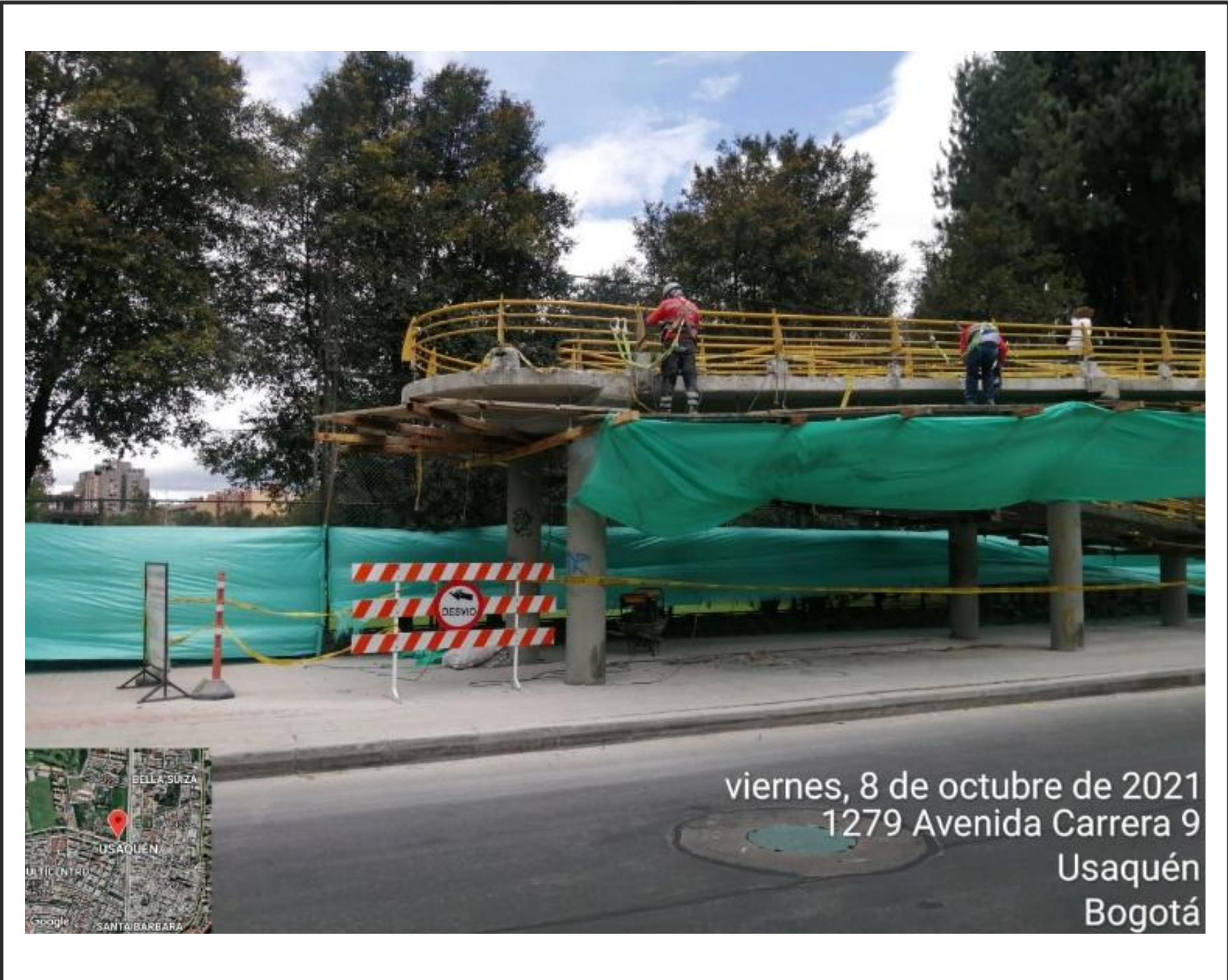
Puente Peatonal AV. Callejas AV. Laureano Gómez (Norte)
