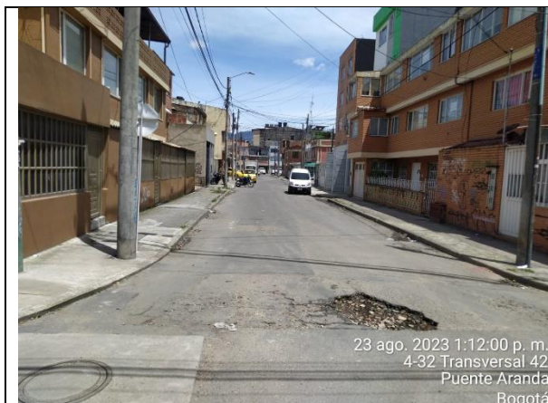
Foto 1. Calle 4 con Transversal 42. Vista oriente.
