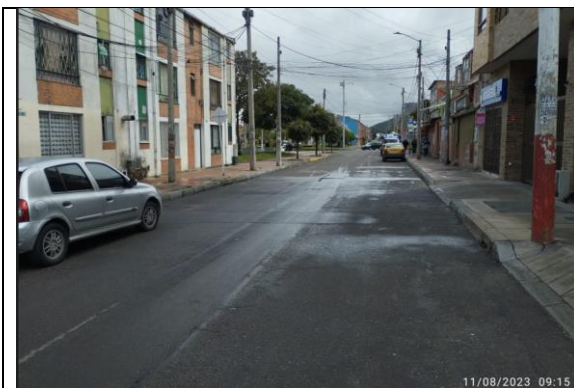
Foto 1. Panorámica KR 8 entre CL 189 y CL 191, vista al occidente.
