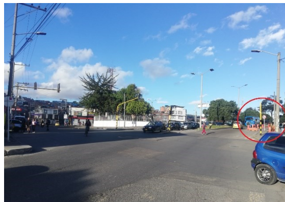
Fotografía 2: Canalización del carril derecho de la Calzada Norte de la AC 22 frente a la estación de policía, afectando el despeje de los movimientos sur – occidente, oriente – sur y norte - occidente.
