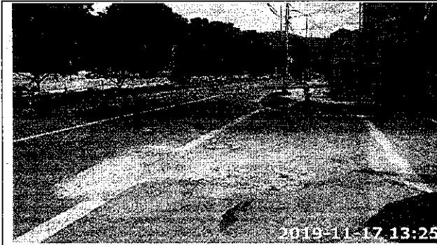
Fotografía 3. Panorámica de la KR 67B por AC 53 (Vista W-E). Se evidencia el mal estado del pavimento.
