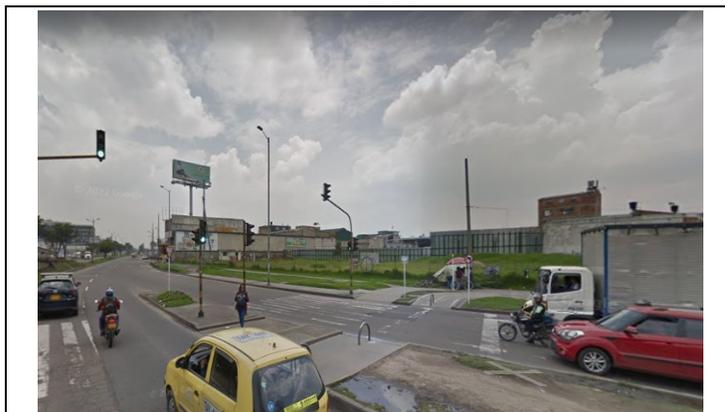
**Fotografía No.1.** Panorámica del sector – Vista al Occidente. Desgaste de señalización horizontal en intersección vial con señal luminosa (semáforo) – desgaste de demarcación en zona de trayectoria peatonal y cruce de ciclistas en gran volumen.
