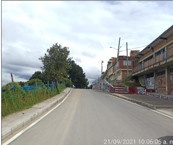
Foto 1. Carrera 4 B Este con Calle 48 B Sur. Vista al norte.
