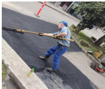
Reparación del pavimento en Modelia 2. Diciembre de 2022
