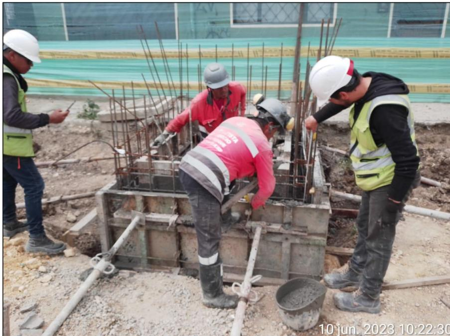
• **Instalación de concreto 4000 psi**
