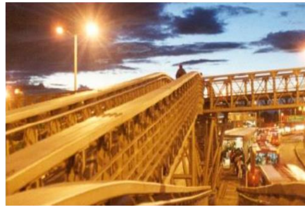
91 Puentes Peatonales asociados a estaciones y portales
