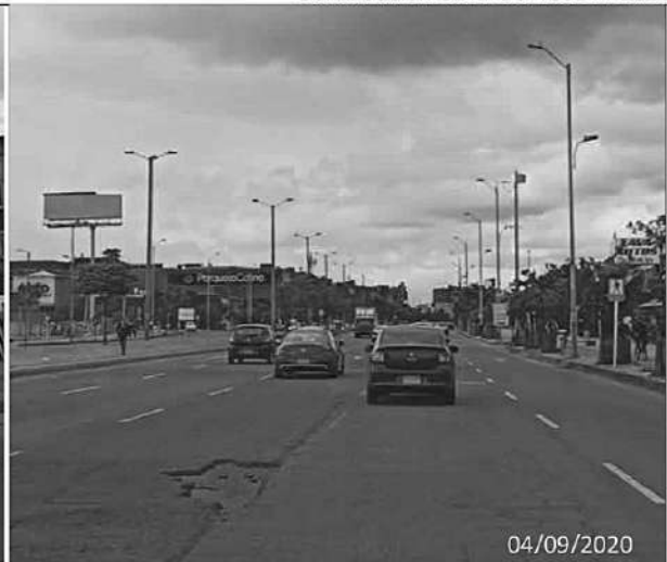
Fotografía 2. Pavimento en regular estado en la AK 72 entre CL 147 y CL 152B. Vista al sur.
