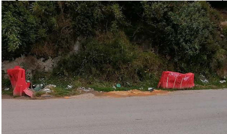
Fotografía 1. Octubre 2020 - Carrera 15 Este con Calle 91 Sur - Tihuaque
