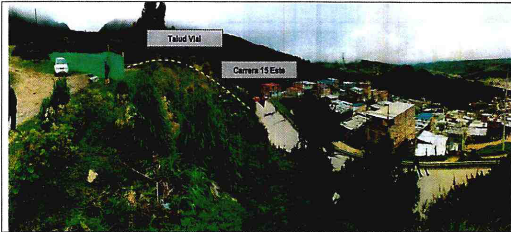
Fotografía 1. Sector de la Carrera 15 Este entre Calle 90D Sur y 91B Sur, en el Barrio Juan José Rondón de la Localidad de Usme.
