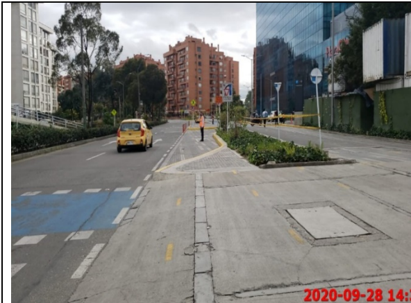
Foto 1- Carrera 68A entre Avenida Calle 24 y 85m al norte: No se evidenció intervención sobre el carril oriental de la calzada oriental
