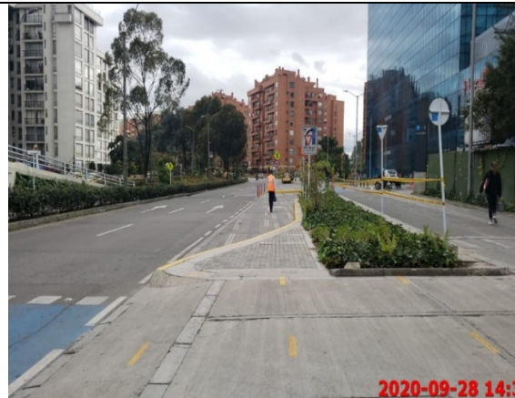
Foto 2- Carrera 68A 20m al norte de la Avenida Calle 24: No se evidenció cierre de espacio público sin autorización.
