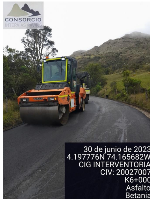
EXTENSIÓN Y COMPACTACIÓN DE MEZCLA ASFLATICA
