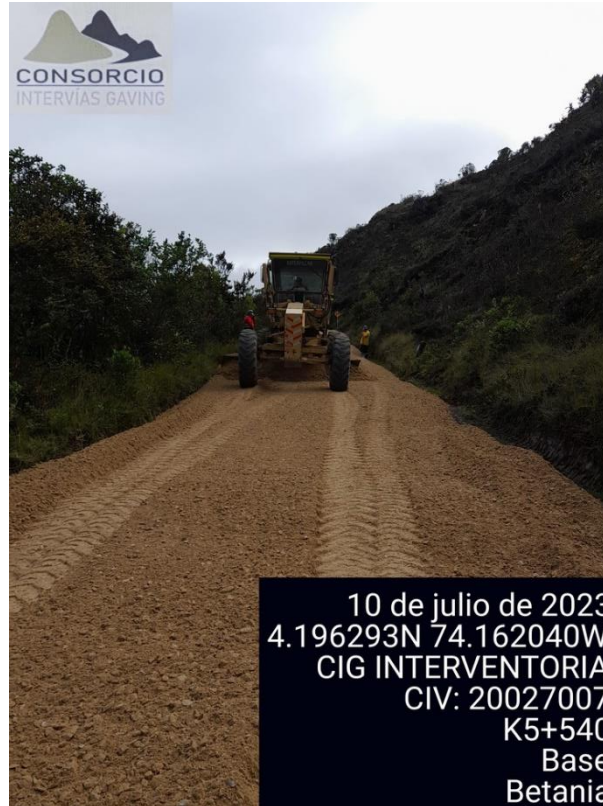
INSTALACIÓN DE BASE GRANULAR
