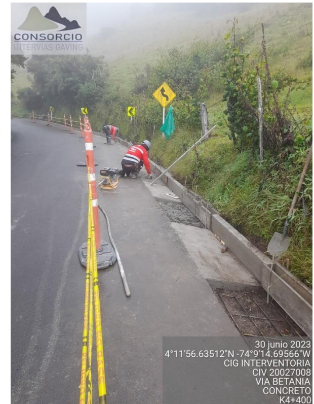
CONSTRUCCIÓN DE CUNETAS
