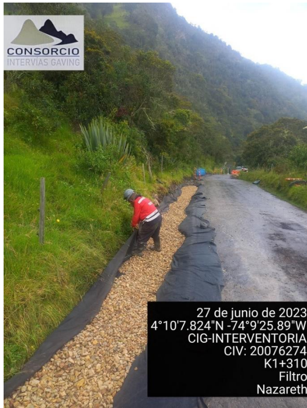
CONSTRUCCIÓN DE FILTROS
