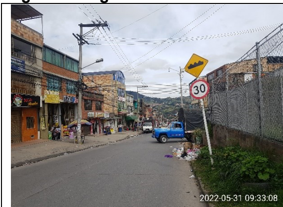
Fotografía 24: Calle 81 Sur Carrera 5, sentido Oriente – Occidente.
