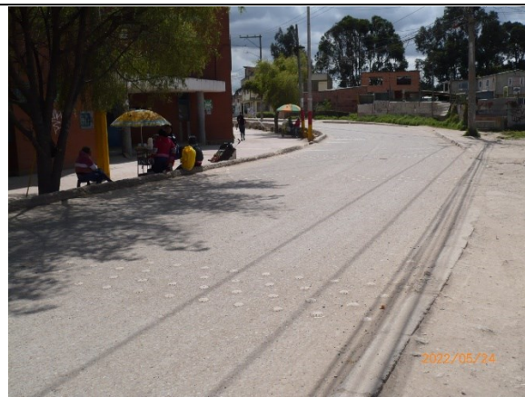
Fotografía 6. KR 87B por CL 79C Sur Vista al Oriente.
