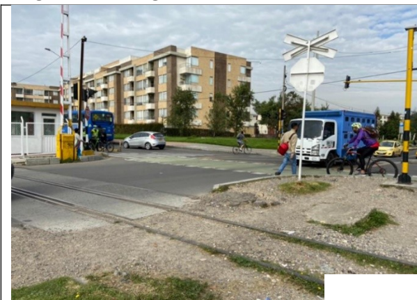
Fotografía No.1. Intersección de la Calle 161 con Avenida Carrera 9. Vista al Oriente.
