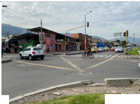
Fotografía No.2. Avenida Carrera 9 con Calle 161. Vista al Sur.
