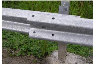
Figura 22. Sujeción de vigas metálicas.
