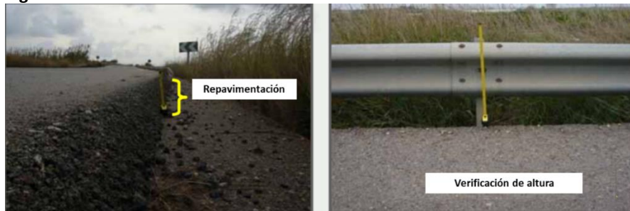
Figura 21. Verificación de altura de la barrera en labores de mantenimiento vial.
