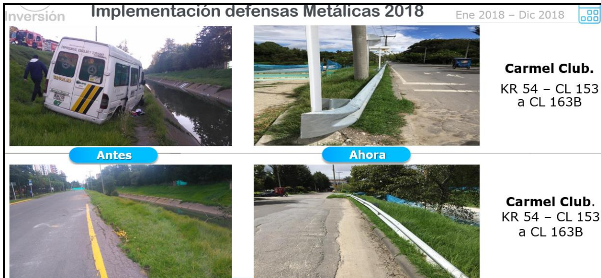
Imagen 6: Implementación defensas Metálicas Carmel Club KR 54- CL 163B, Carmel Club KR 54 - CL 153 a CL 163B. Localidad de Suba. 2019
