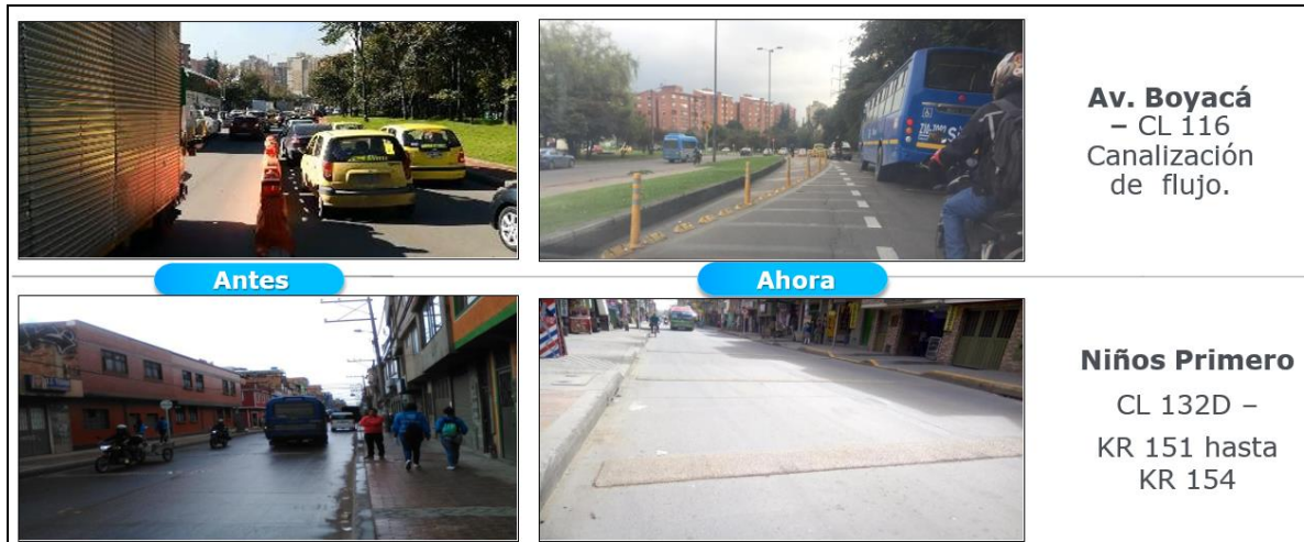
Imagen 5: Canalización de flujo Av. Boyacá CL 116. Niños Primero CL 132D- KR 151 Hasta KR 154. Localidad de Suba. 2019.
