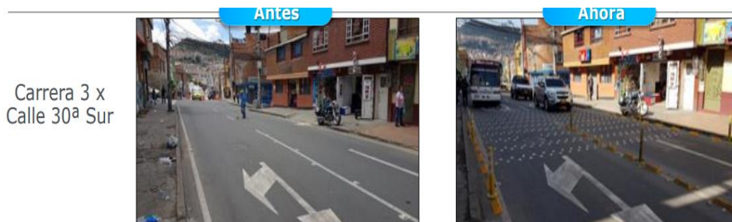
Imagen 6: Cra 3 por Clle 30 A sur. 20 de Julio Localidad de San Cristóbal 2019.
