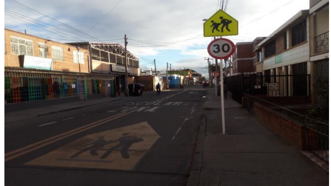
Imagen 4. Demarcación y señalización de zona escolar en la kr 98 con cl 18. Localidad de Fontibón. 2019.
