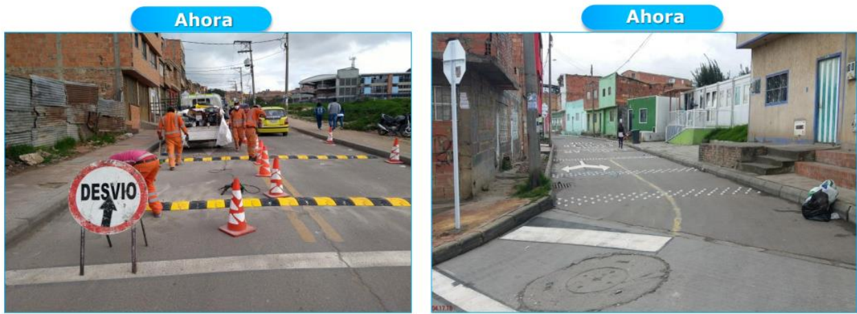
Imagen 4: Implementación en vía, Carrera 17 F con Calle 78 Sur - Colegio Calasanz Localidad de Ciudad Bolívar. 2019.
