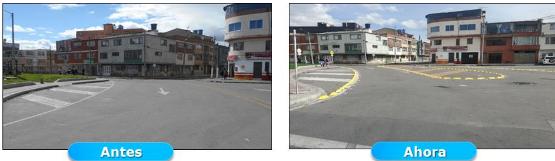
Imagen 4: Demarcación en vía, carrera 19 Bis por calle 1F, Localidad de Los Mártires. 2018.
