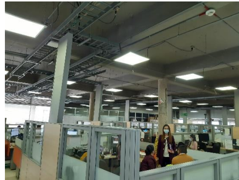
Mantenimiento luminarias área SC. Sede Calle 13
