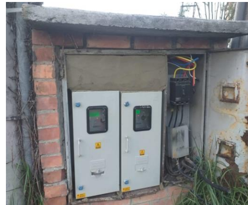
Adecuación de medidores generales. Sede Fontibón 2.
