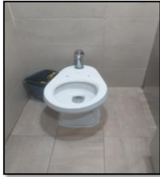
Reposición sanitario baño mujeres cafetería calle 13 tanque sede casa 21
