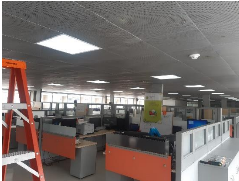
Mantenimiento luminarias área SSC. Sede Calle 13
