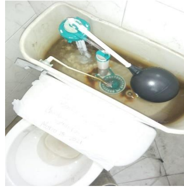
Reposición de árbol ahorrador de entrada y salida en sanitario de
