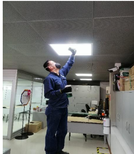
Limpeza de luminarias tecnología LED
