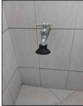
Sistemas de bajo consumo implementados en los puntos de agua
