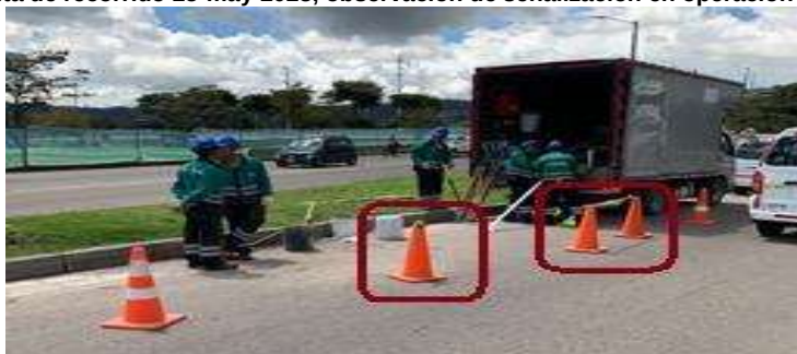
Imagen No. 3. Visita de recorrido 25-may-2023, observación de señalización en operación Localidad de Suba.
