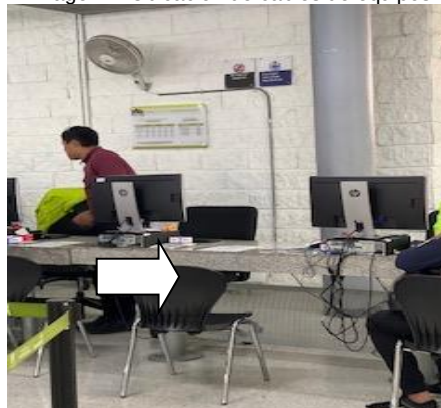
Imagen 7: Ubicación de cables de equipos
