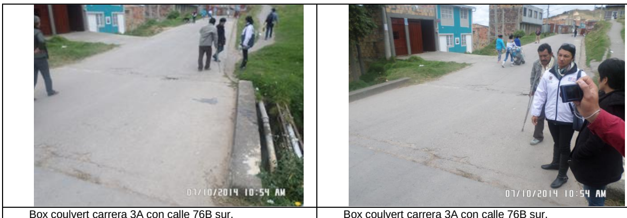
Box coulvert carrera 3A con calle 76B sur.
