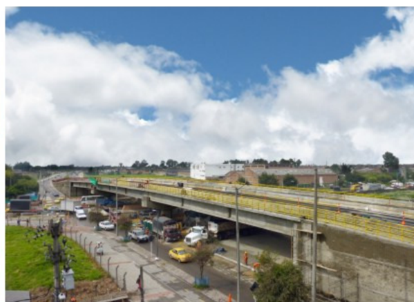
Durante la construcción
