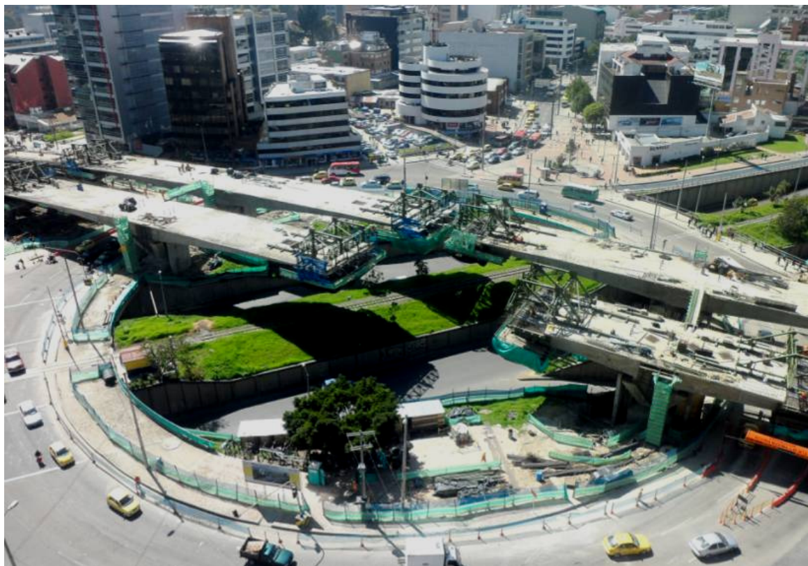
Durante la construcción
