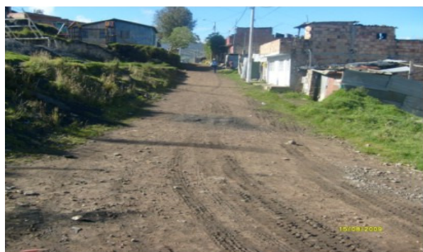
CARRERA 7 ENTRE CALLES 113 SUR Y 114 SUR - ANTES
