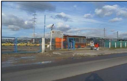
Mejoramiento de la entrada al patio
