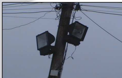
Mejoramiento de iluminación
