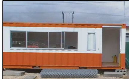
Instalación de contenedores para nuevas oficinas
