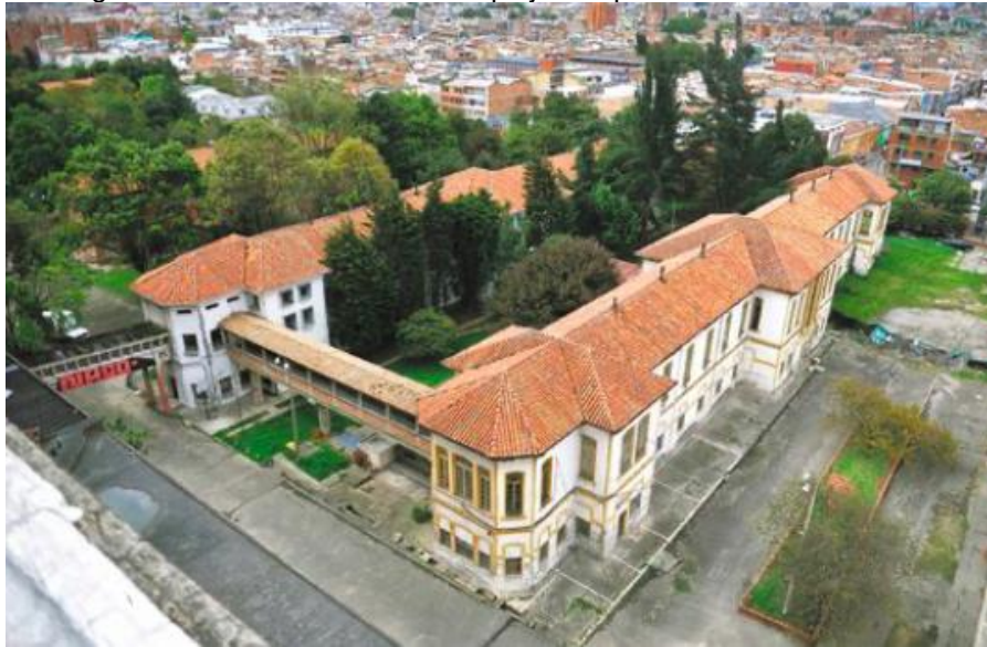
Fotografía 36. Vista aérea del Complejo Hospitalario San Juan de Dios.
