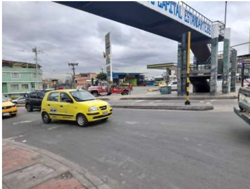
Figura 59. Vista lateral del puente peatonal sobre la Av. Caracas a la altura de la Diagonal 51 B sur
