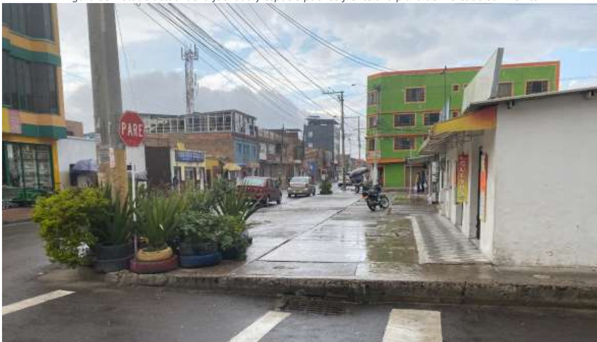
Figura 38. Estado actual de la fachada y espacio público frente a la plaza de mercado San Benito
