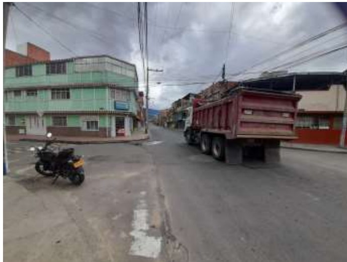
Ausencia de rampas en las esquinas
