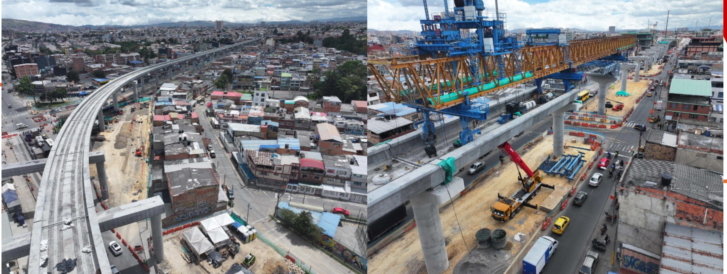
Tramo Av primera de mayo
