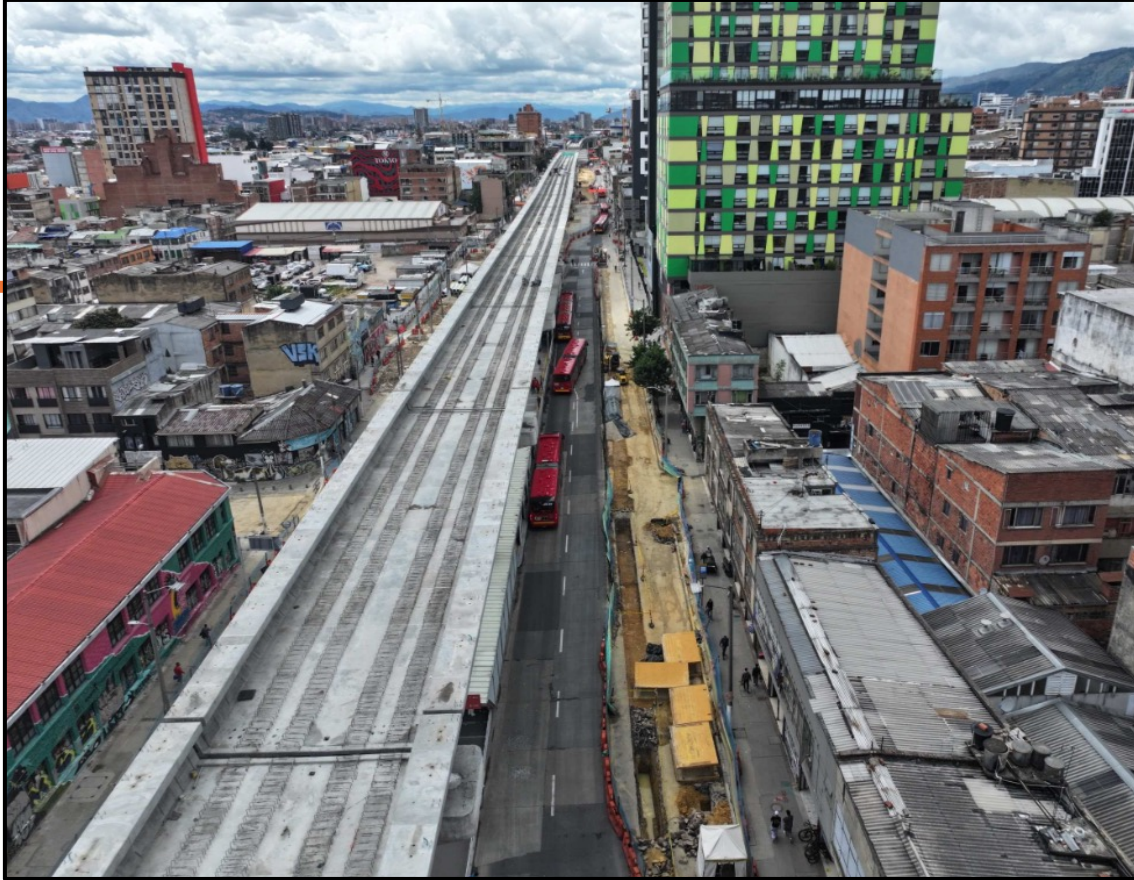
Tramo calles 60 y 54
