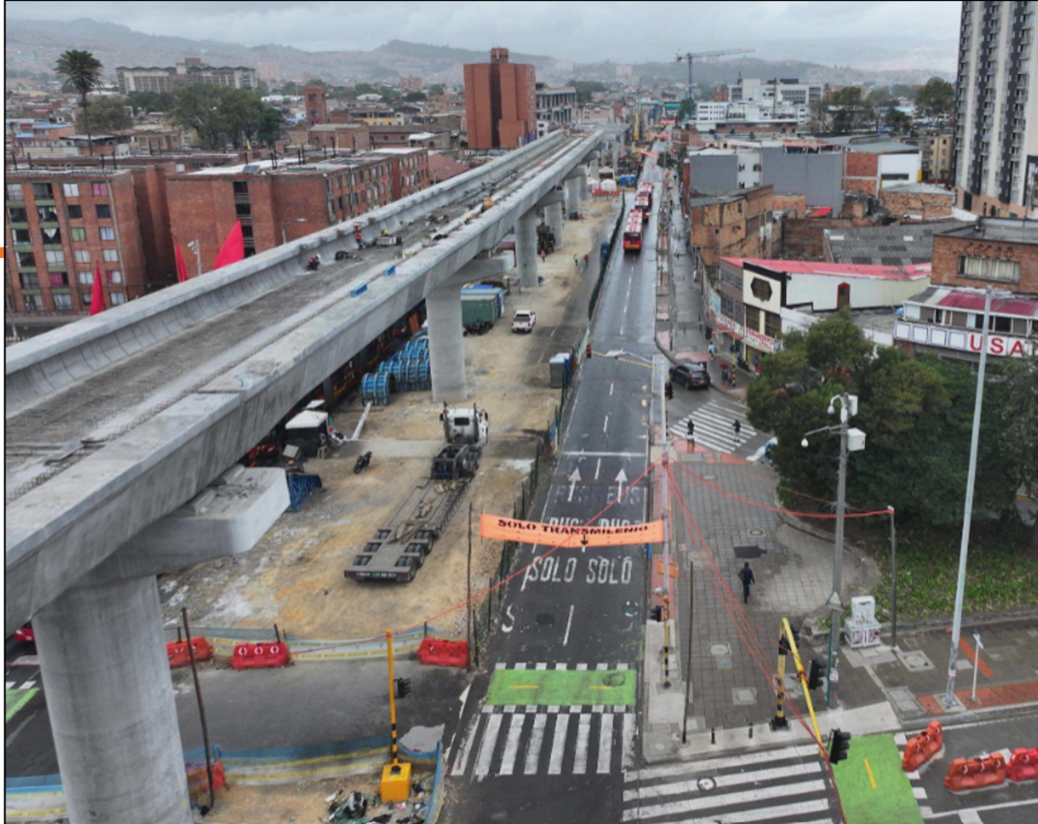
Tramo calle 1 Y 6
