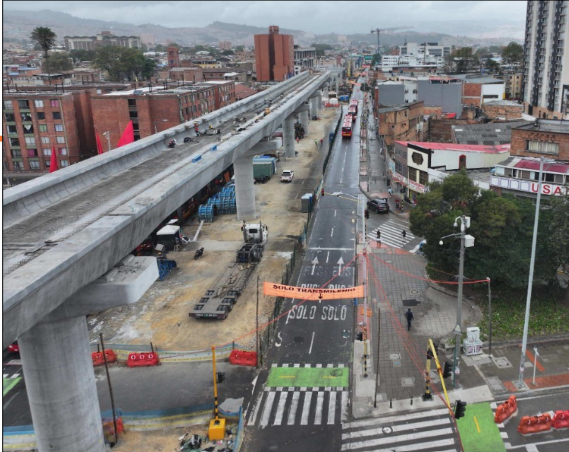
Tramo calle 1 Y 6
