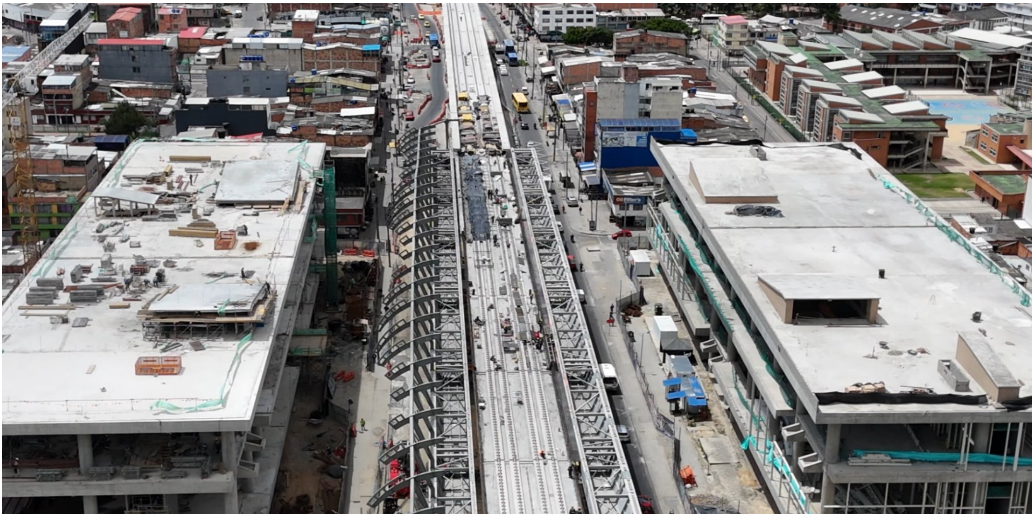
Estación 5 Av. 1 de Mayo entre calles 40 Sur y 39 Sur
