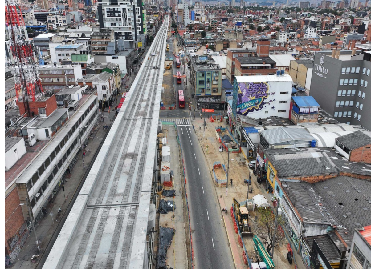
Tramo Calles 60 y 58
