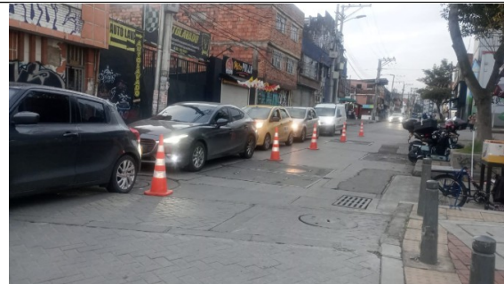
Implementación de conos para garantizar acceso vehicular adecuado en la Calle 12 Bis.
