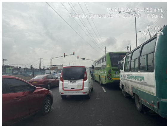
Fotografía 5. Av. Carrera 68 con Calle 17, intersecciones semaforizadas de alta demanda.
