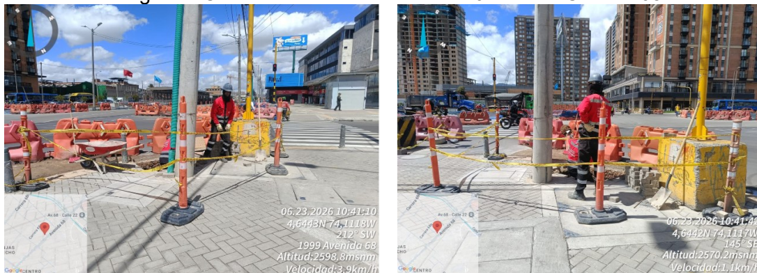
Imagen 2. Costado nororiental en calle 20 con Av. Carrera 68
