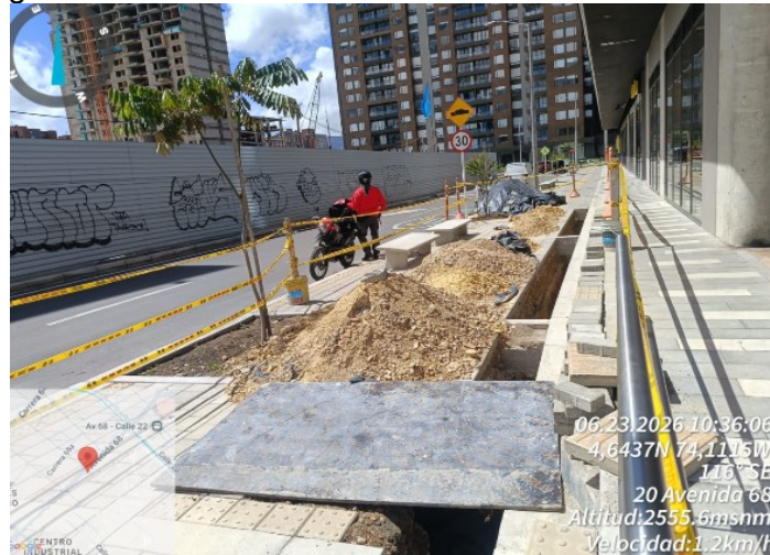
Imagen 1. Costado suroriental en calle 20 con Av. Carrera 68
