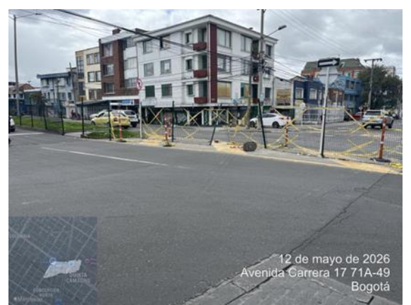
Foto No. 6 CL 72 con KR 17, vista al Norte.
