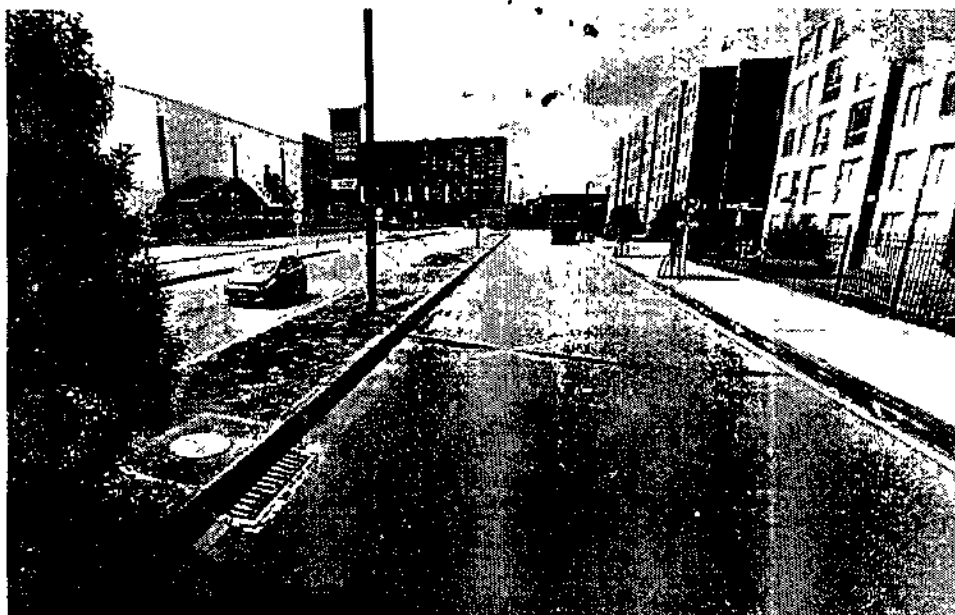
AMPLIACIÓN REGISTRO FOTOGRÁFICO ORDEN DE COMPARENDO No. 11001000000010396739
