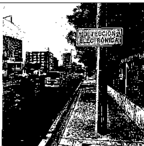
Fotografía 1. Señalización informativa tipo SI-27 implementada en la Av. carrera 9 entre calle 139 y calle 140 – Sentido Sur - Norte
