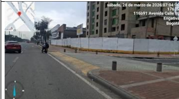
Foto 7. Panorámica bocacalle KR 116B con AC 80 (calzada sur), vista al oriente.
