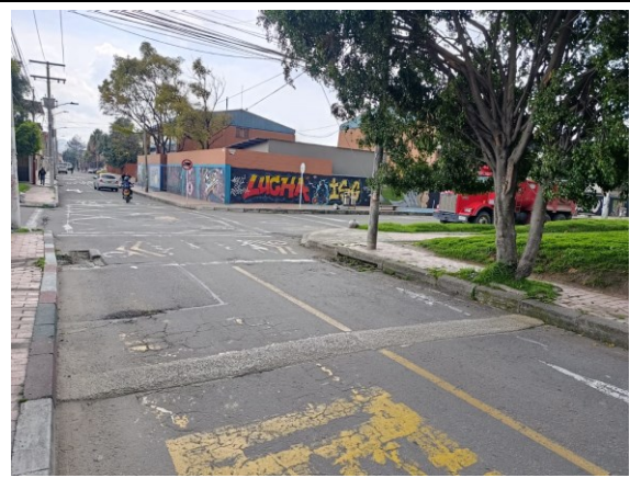
Foto 6. Panorámica KR 23 entre CL 36 Sur y CL 37 Sur, vista al occidente.
