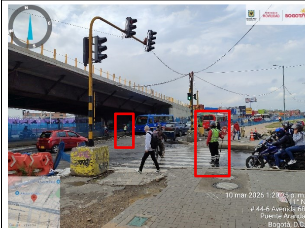
Fotografía 5. Intersección de la Av. Carrera 68 por Calle 44 Sur. Vista Sur-Norte.
