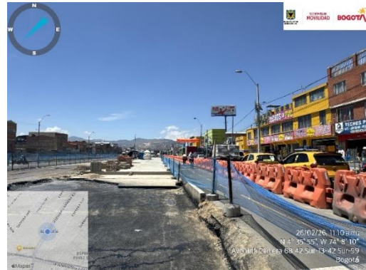
Fotografía 6. Panorámica de la Av. Carrera 68 entre Calle 42 Sur y Calle 43 Sur. Vista Norte-Sur.
